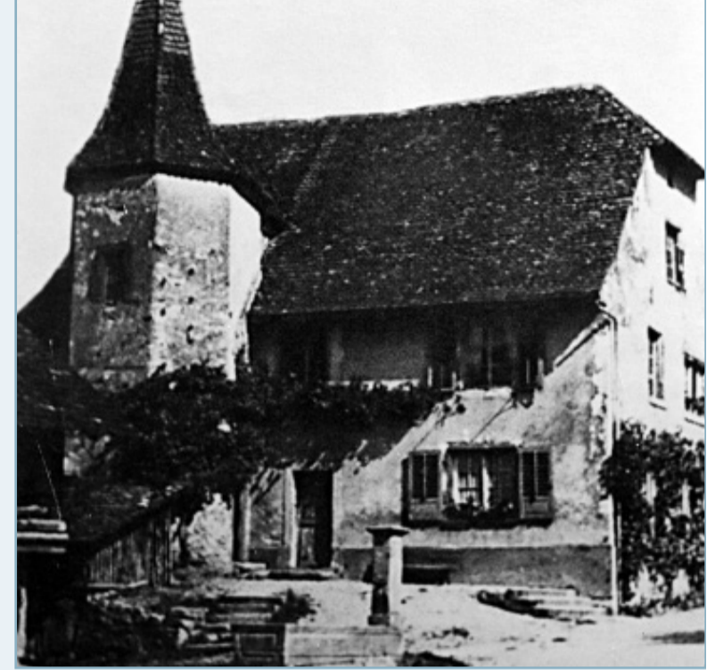
Das Schönauer Schösschen in Oeschgen vor der Renovation
