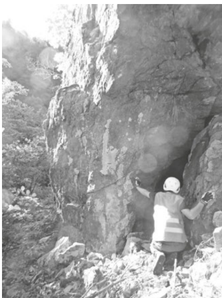
Im Wehratal muss unter anderem dieser Felsblock gesichert werden/ Bild: RP Freiburg
